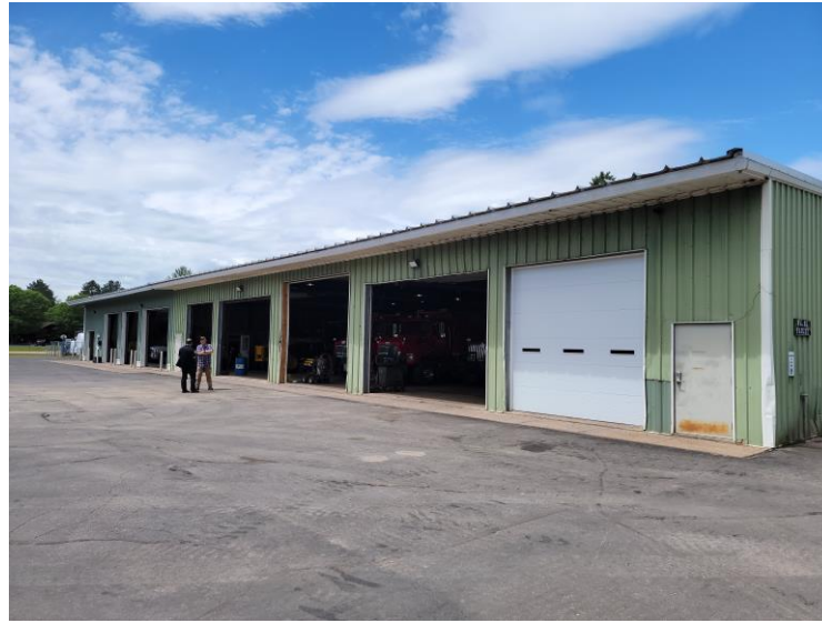
SE View, Garage Door Limitations
